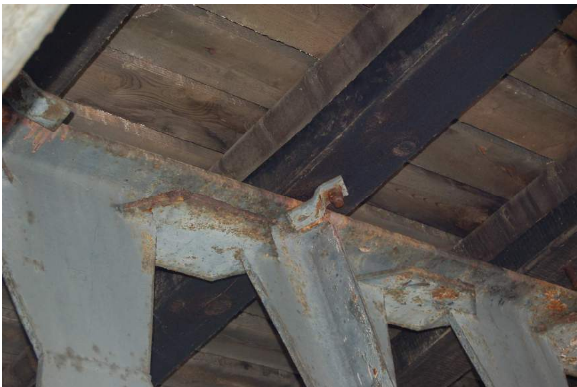
Fot. 5. Mocowanie belek poprzecznych do dźwigarów
