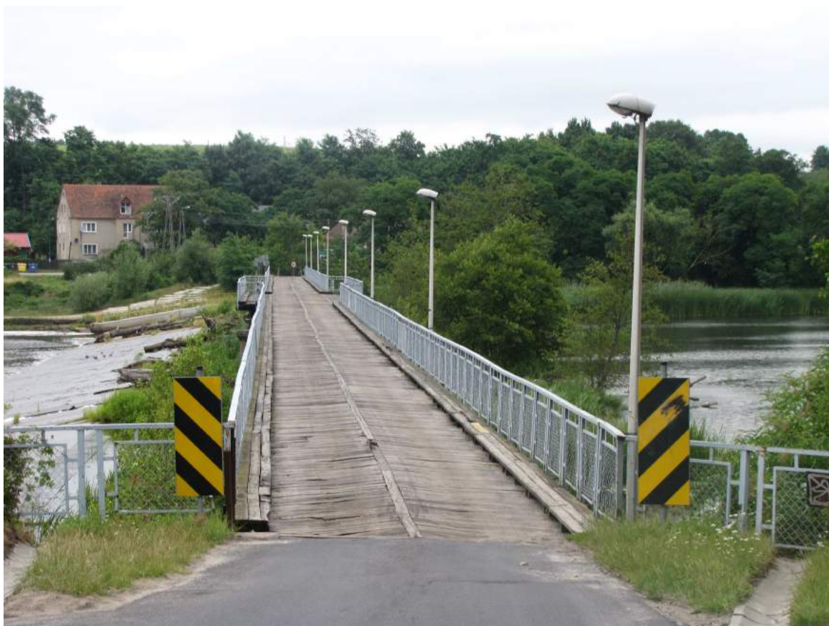
Fot. 1. Widok na most od strony Dychowa
