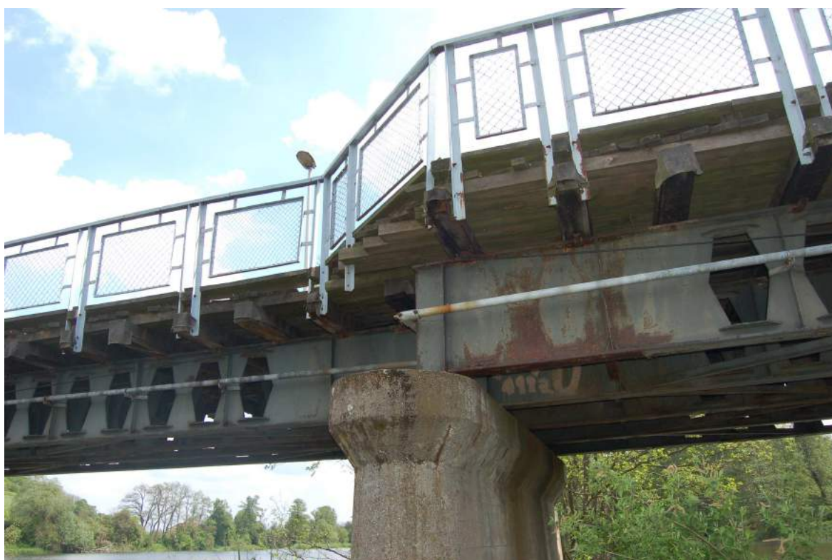
Fot. 7. Mocowanie balustrad do belek poprzecznych
