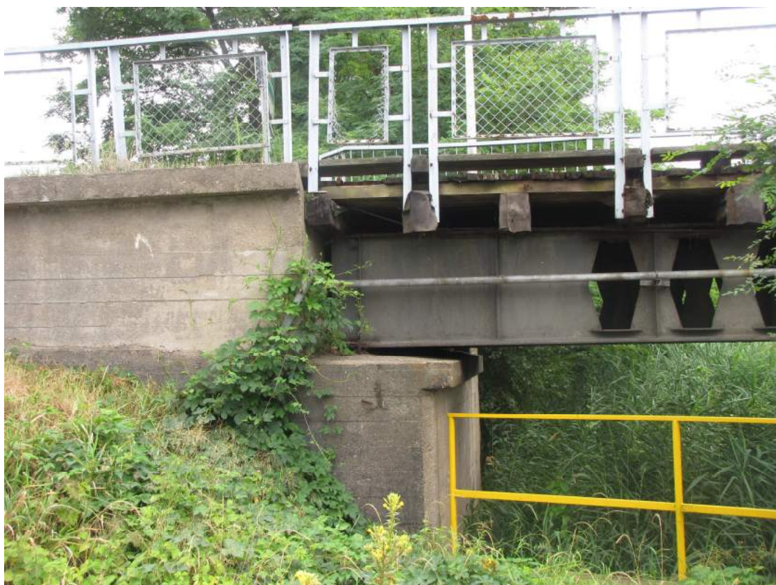
Fot. 10. Widok z boku na przyczółek od strony Prądocinka
