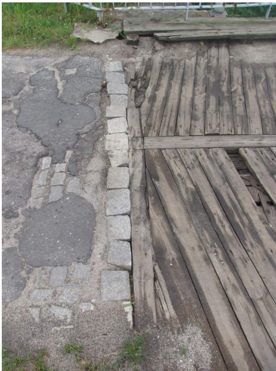
Fot. 11. Nawierzchnia na obiekcie i dojeździe do obiektu
