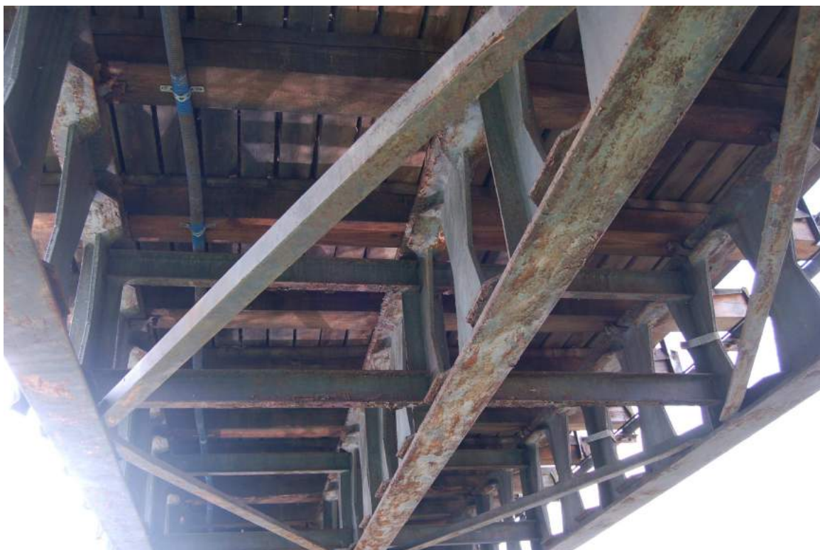
Fot. 4. Widok od spodu konstrukcji
