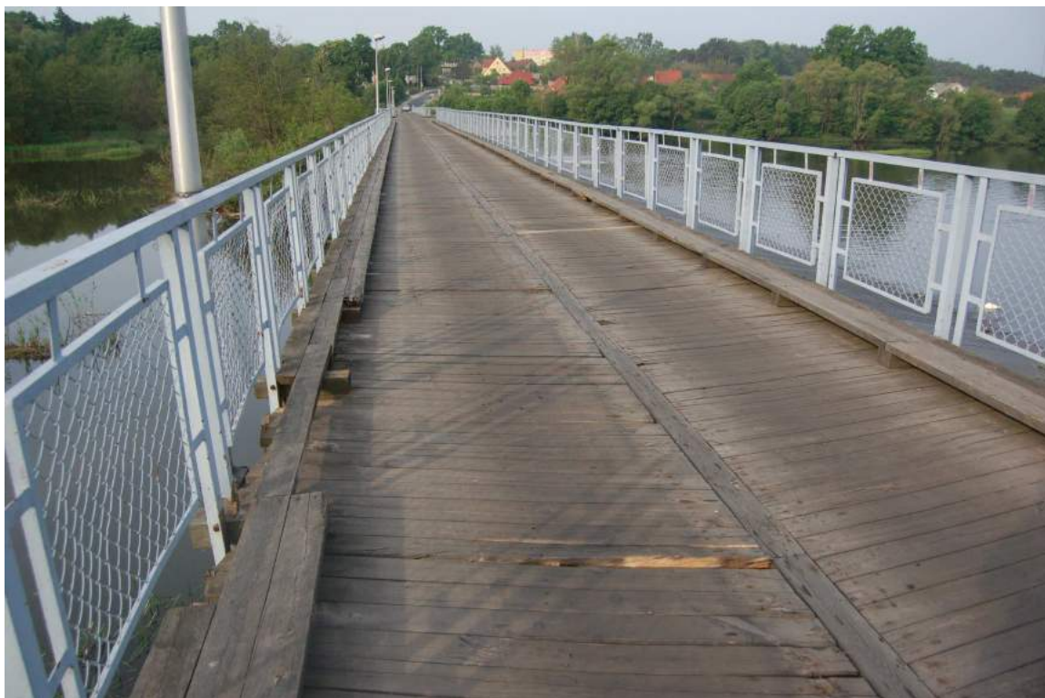
Fot.2. Drewniana nawierzchnia jezdni
