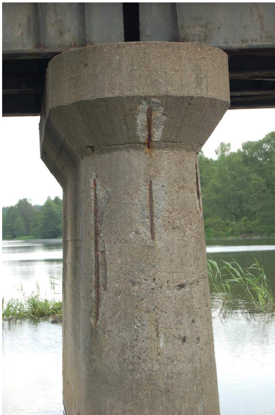
Fot. 8. Widok na filar
