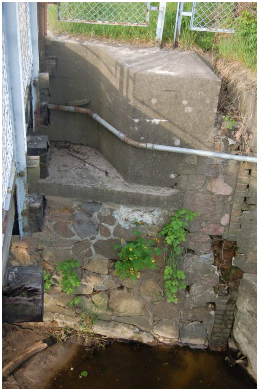
Fot. 9. Widok na przyczółek od strony Dychowa
