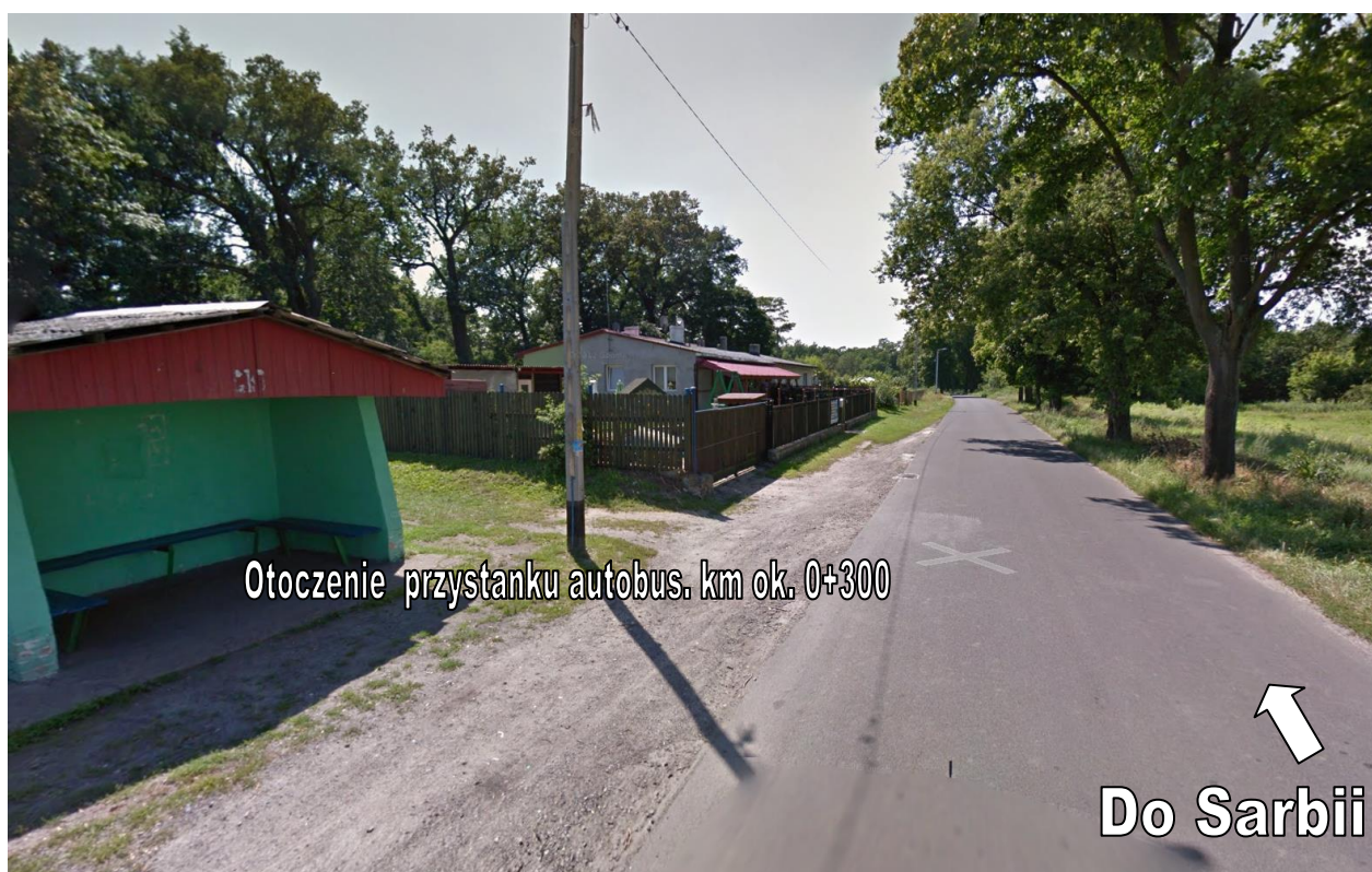
Fotografia nr 2. Teren planowanego peronu przy przystanku autobusowym km ok. 0+300
